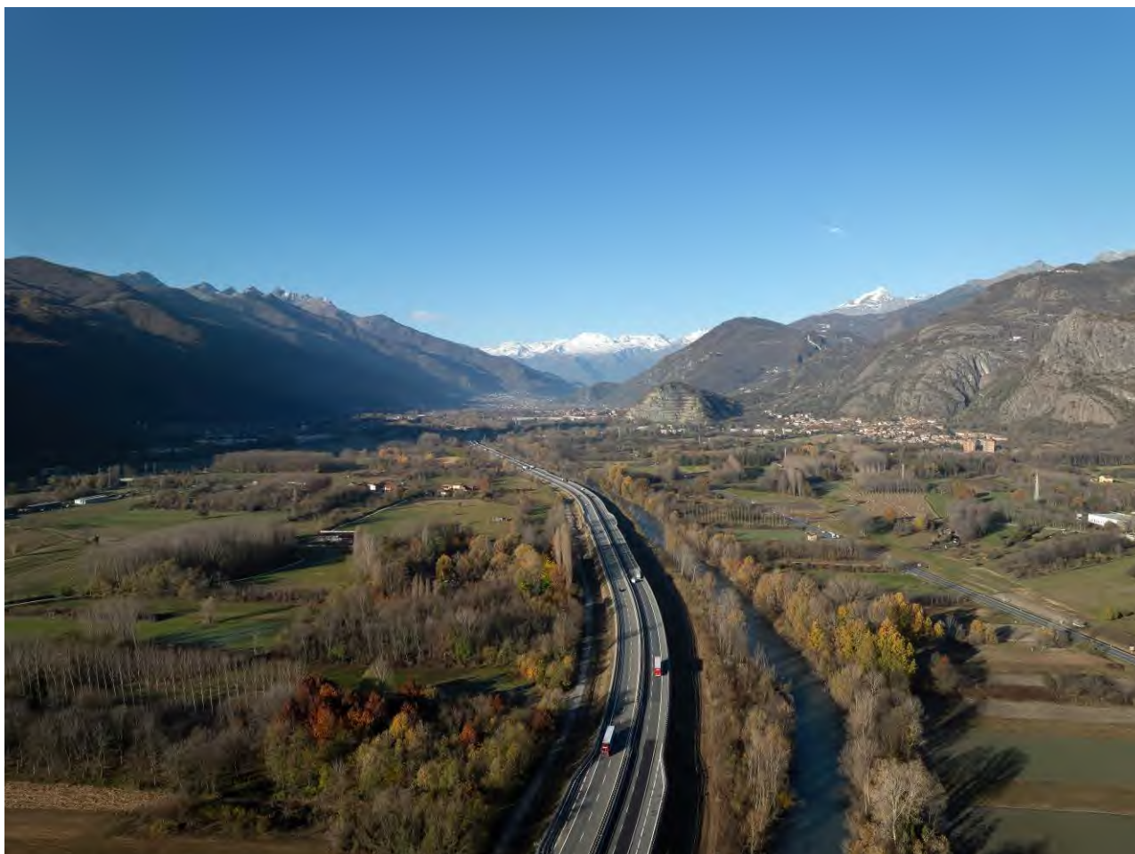
Figura 16 - Tratta A32 direzione Bardonecchia
